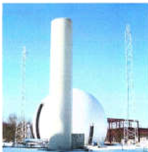
Рис. 2.8 - Общий вид сооружений газового хозяйства
