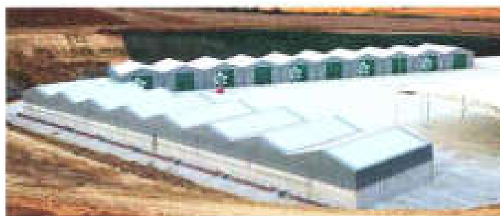
Рис. 2.9 - Общий вид сооружений аэробной стабилизации отходов
