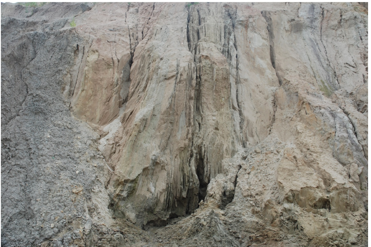
Рисунок 3.21 – Обнажение вертикально залегающих пластов палеогеновых и неогеновых отложений в северо-восточной стенке карьера (между карьерами линз №№ 9 и 10 месторождения мела и глин Колядичи II)
