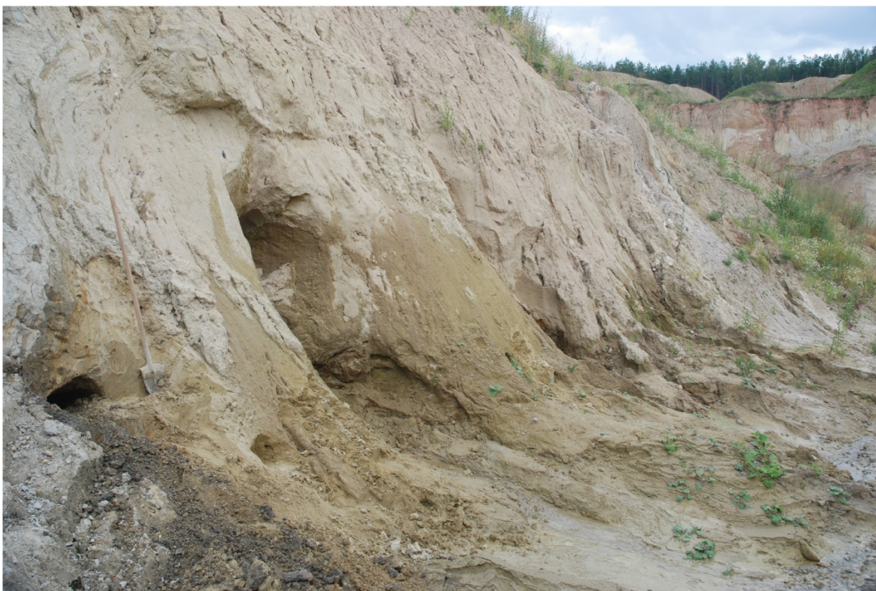
Рисунок 3.23 – Разгрузка подземных вод в нижней части северо-восточной стенки карьера (между карьерами линз мела №№ 9 и 10 месторождения мела и глин Колядичи II)
