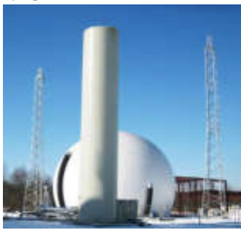
Рис. 2.6. Общий вид сооружений
