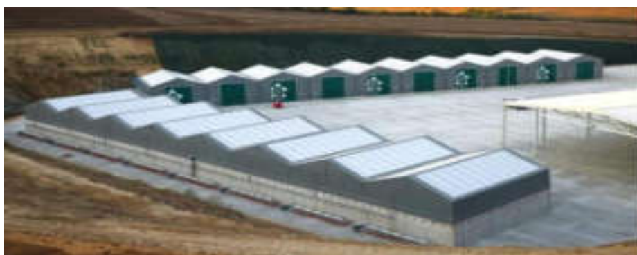
Рис. 2.7. Общий вид сооружений аэробной стабилизации
